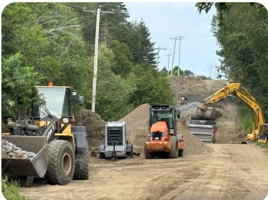
(Photo prise lors des travaux)
