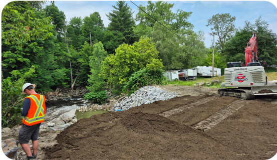
(Photo prise lors des travaux)
